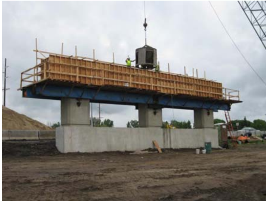
Concrete pour of pier 1's cap section
