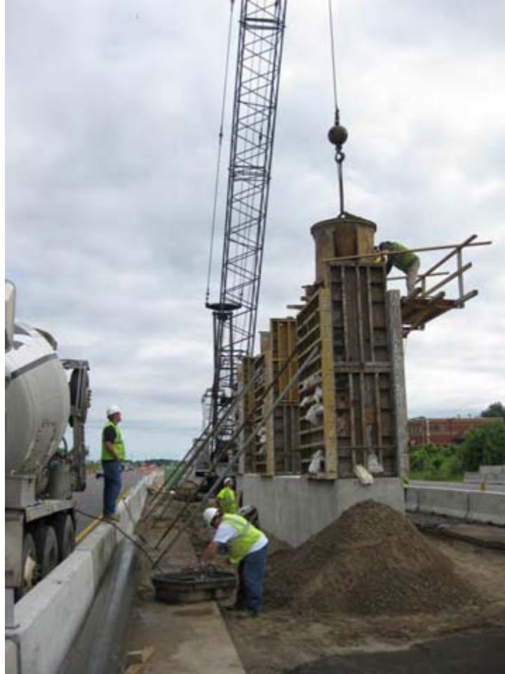
Pouring of pier 3's columns
